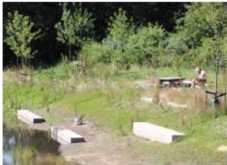
Betonplinte i skrænt
