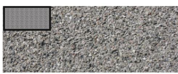
Pinnatud asfalt - Barrikade
