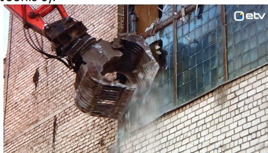
Joonis 4. Tavapärase lammutamise halb näide (Dvigateli tehase) klaasi ning kivimaterjalide koos lammutamisest, mille tulemusel materjalid segunevad.
