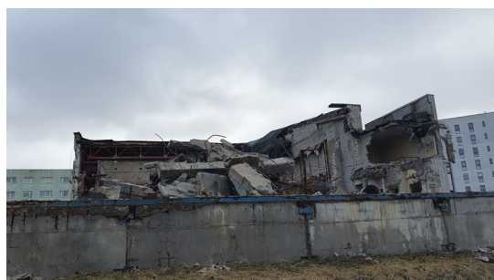
Joonis 5. Tavapärase lammutamise halb näide (Mai kultuurikeskus Pärnus), kus hoones kasutatud materjale ja ehitustehnilisi lahendusi arvestades saanuks osa neist korduskasutada kuid seda ei tellitud.
