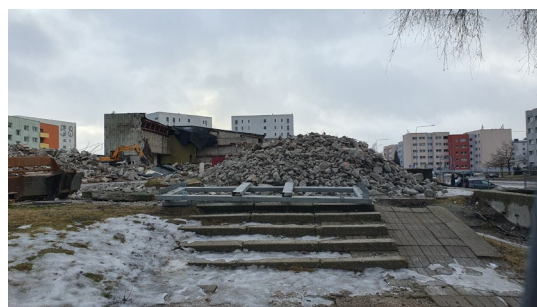
Joonis 5. Tavapärase lammutamise halb näide (Mai kultuurikeskus Pärnus), kus hoones kasutatud materjale ja ehitustehnilisi lahendusi arvestades saanuks osa neist korduskasutada kuid seda ei tellitud.
