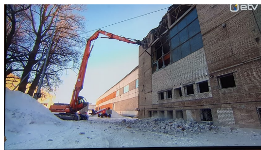
Joonis 4. Tavapärase lammutamise halb näide (Dvigateli tehase) klaasi ning kivimaterjalide koos lammutamisest, mille tulemusel materjalid segunevad.
